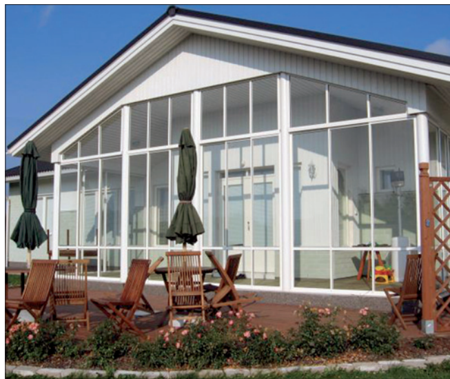
Kiinteän, jaetun 1-lasisen lasituksen asennus
